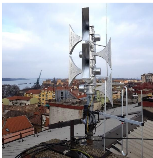
Slika 9. Primjer izvedene elektronske sirene
